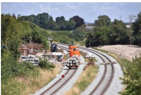
Vst er base for arbejde med at ramme mastefundamenter ned mellem Gz og Rg. Foto ondag 22. juli 2020.
